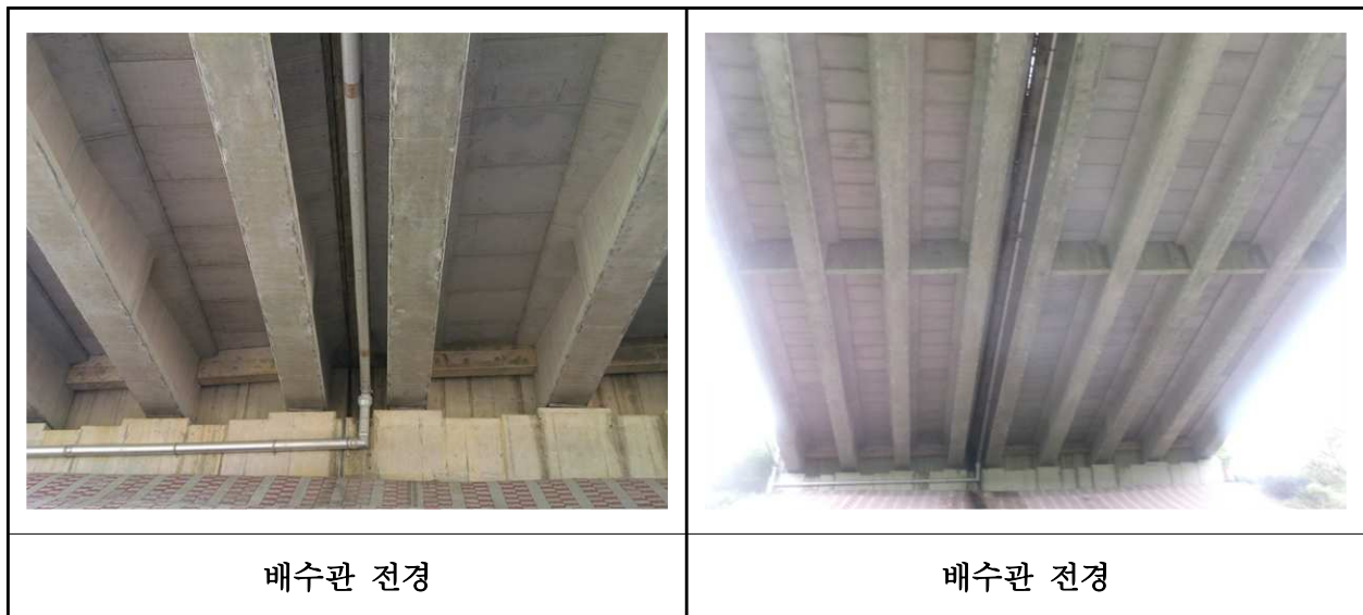
【사진 12.3.44】 배수시설 전경
