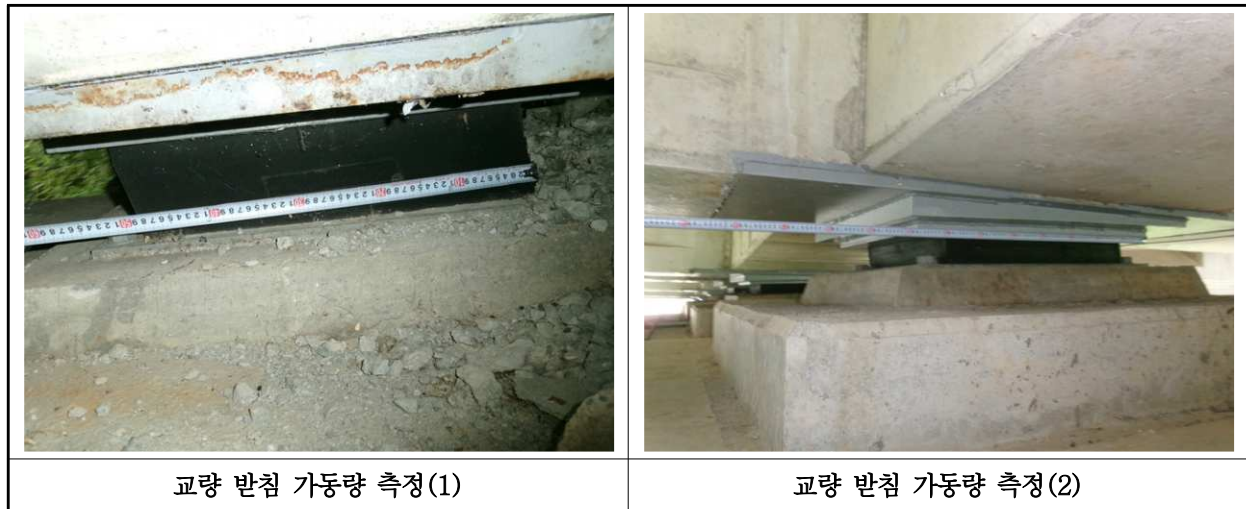
【사진 12.3.38】 교량받침 이동량 측정
