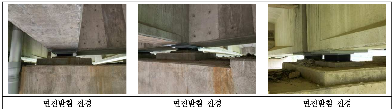
【사진 12.3.35】 교량받침 전경
