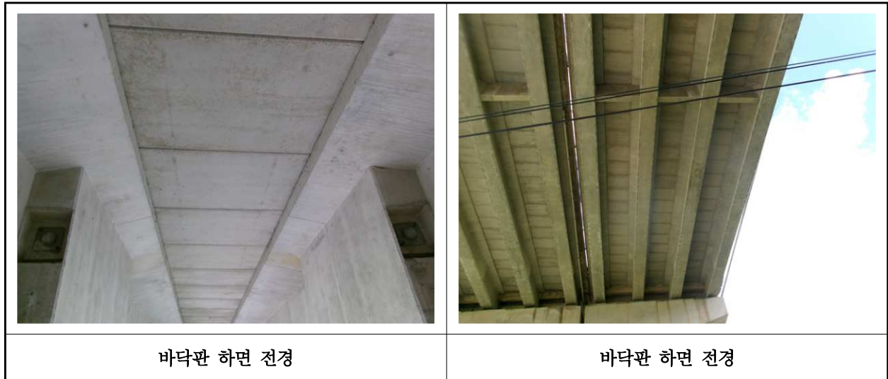
【사진 12.3.2】 바닥판하면 전경
