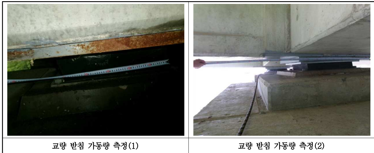
【사진 12.3.15】 교량받침 이동량 측정
