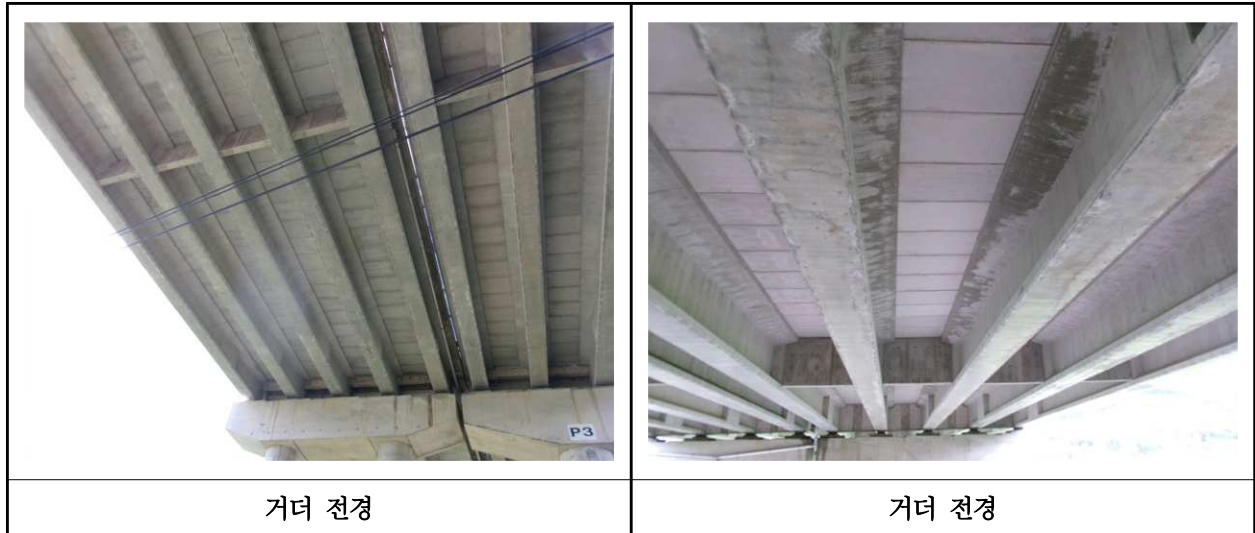
【사진 12.3.27】 거더 전경
