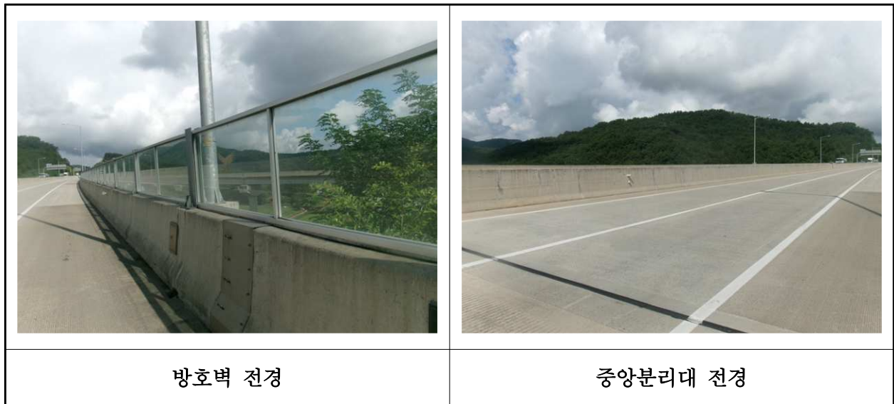
【사진 12.3.23】 방호벽 및 중앙분리대 전경
