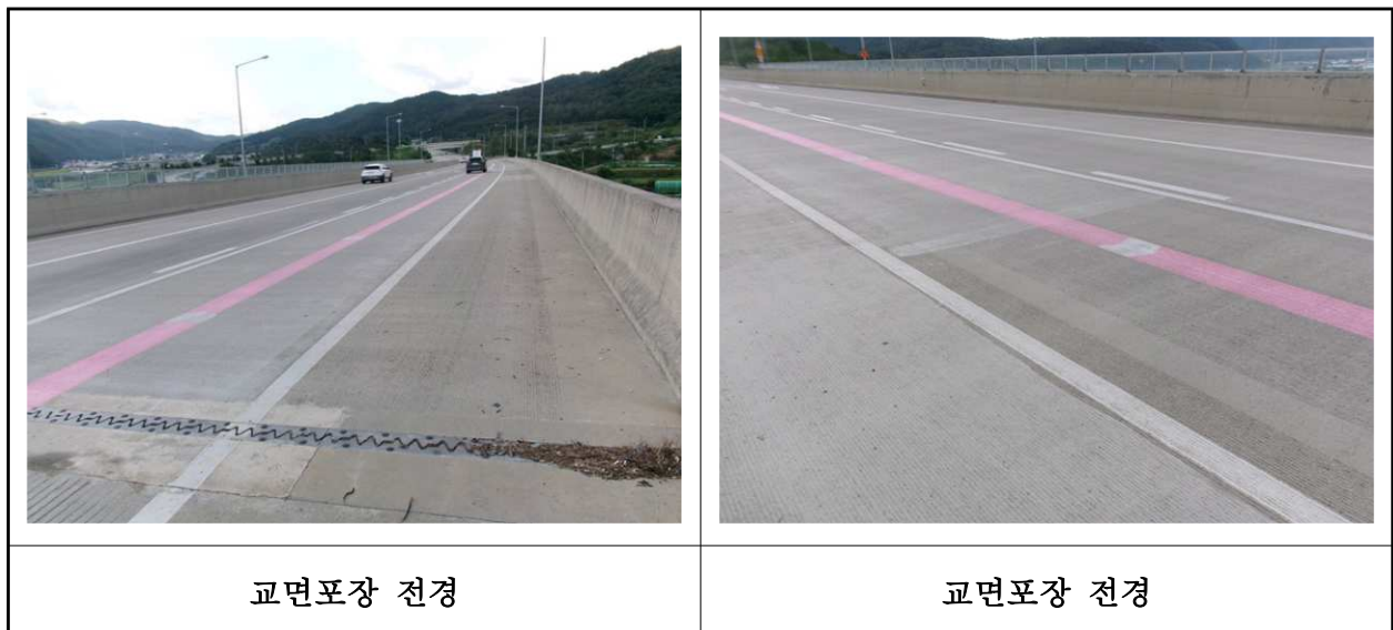
【사진 12.3.42】 교면포장 전경
