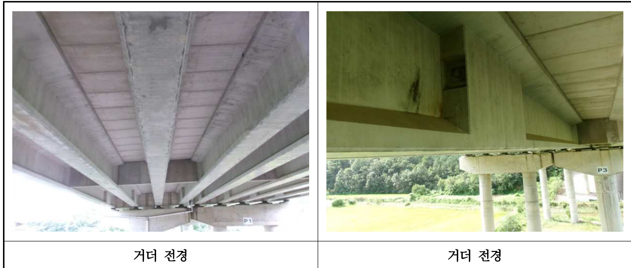
【사진 12.3.4】 거더 전경
