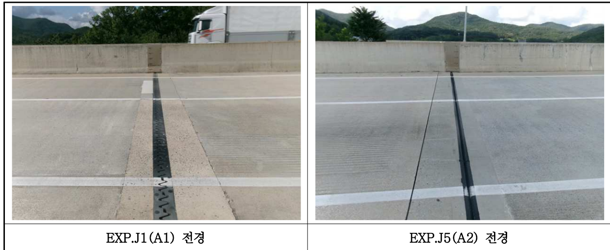
【사진 12.3.16】 신축이음장치 전경
