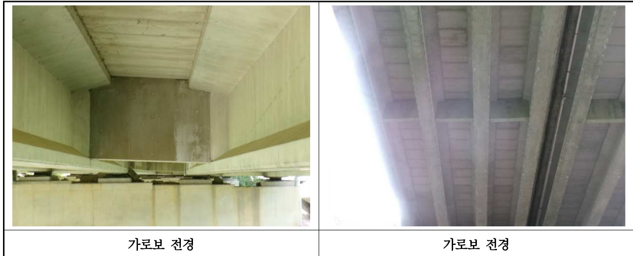
【사진 12.3.6】 가로보 전경
