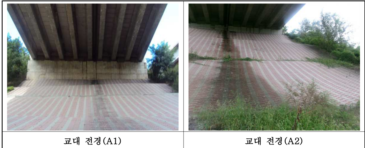
【사진 12.3.31】 교대 전경
