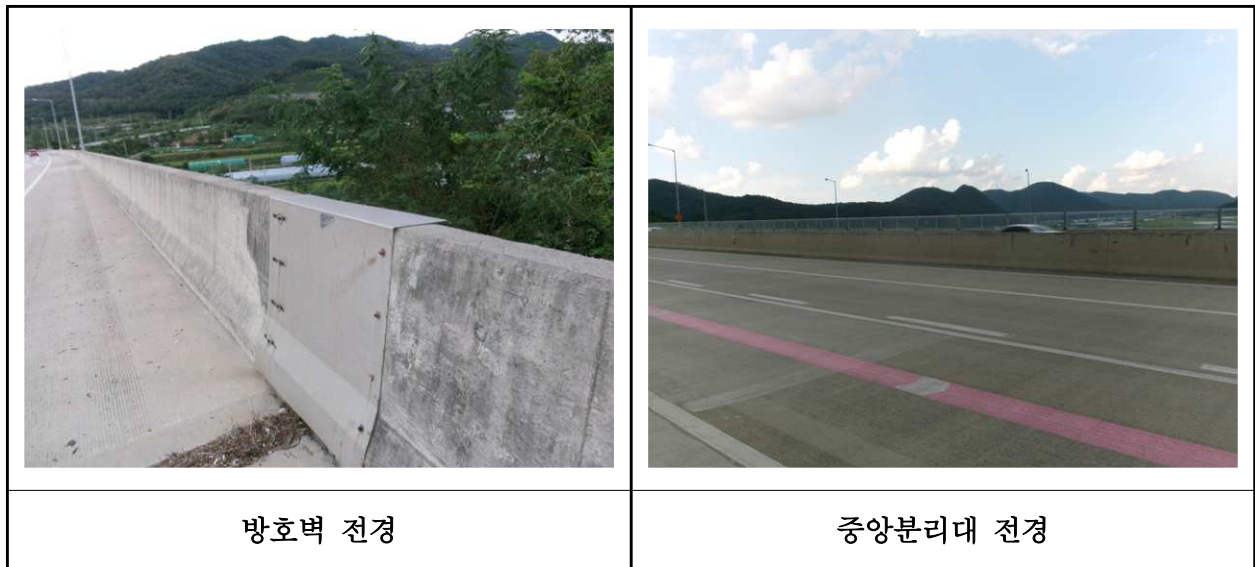
【사진 12.3.46】 방호벽 및 중앙분리대 전경
