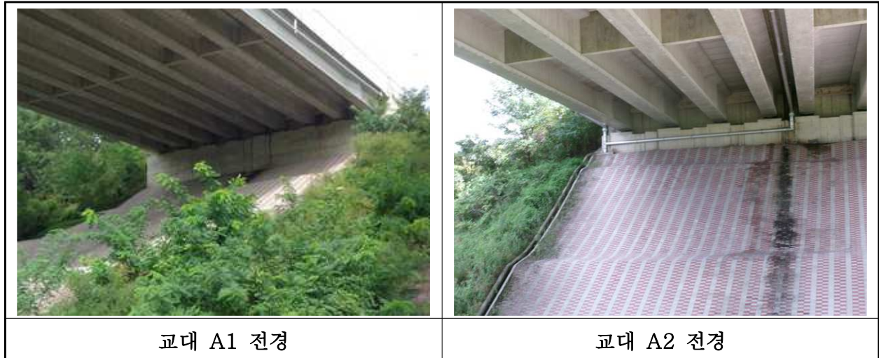
【사진 12.3.8】 교대 전경
