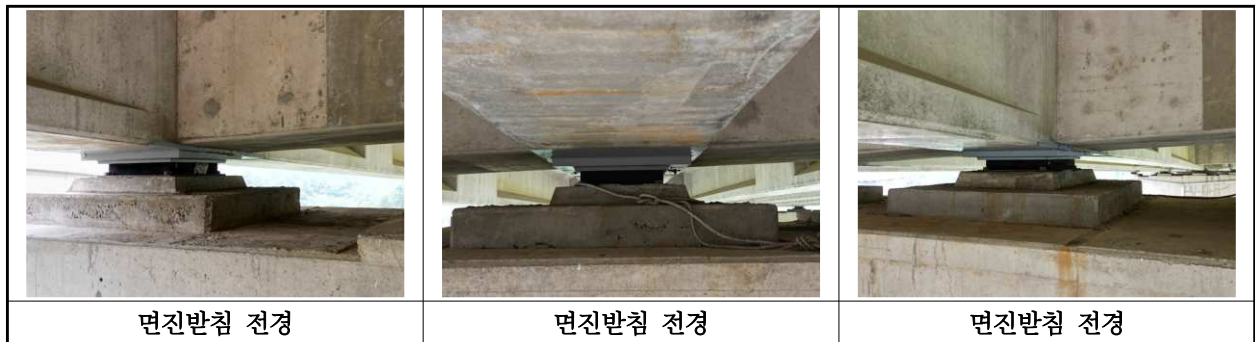
【사진 12.3.12】 교량받침 전경
