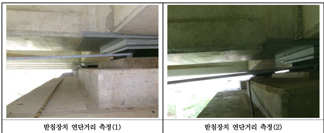
【사진 12.3.37】 교량받침장치 연단거리측정
