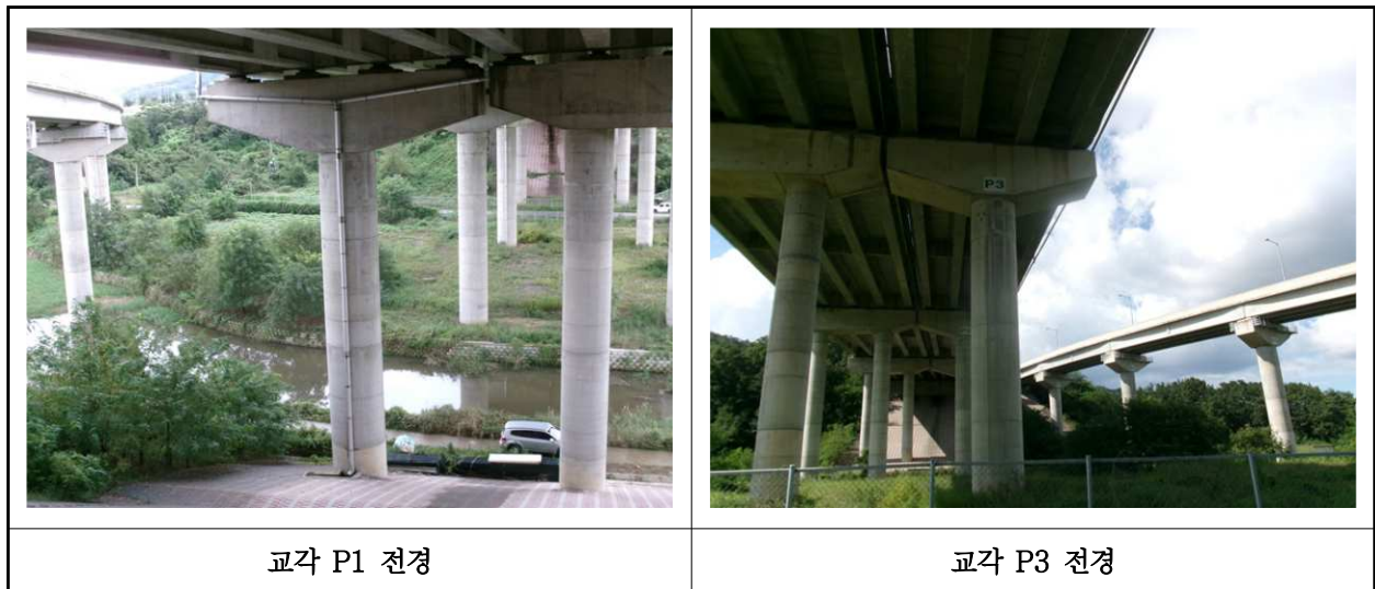
【사진 12.3.10】 교각 전경
